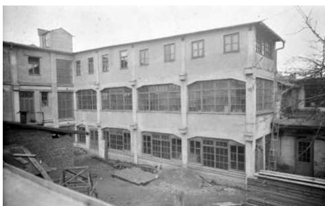
Objekt Hajnooy truhlárny
