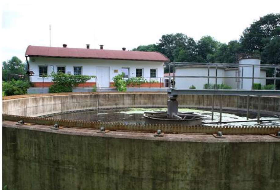
OBRÁZEK 3 ČISTÍRNA ODPADNÍCH VOD V SOLNICI
